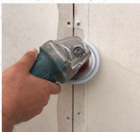
1. Mài vát cạnh dọc khe nối tấm (Rộng: 6 - 7cm, sâu: 5mm)
