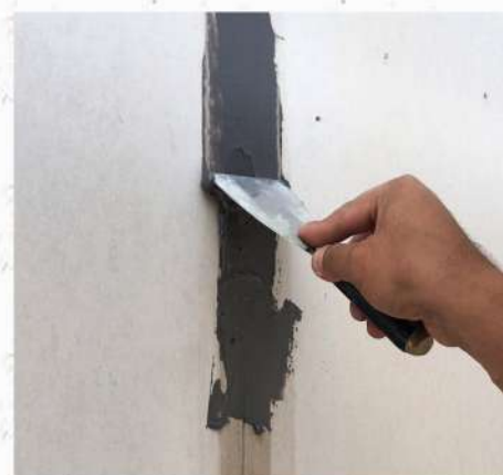
2. Trám phẳng keo D8 Filler dọc vết nứt (chờ khô sau 24h)
