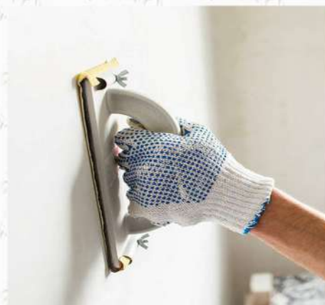
4. Bả matis toàn bộ bề mặt tường, trần nhám phẳng lớp matis tới khi lộ hoàn toàn lớp bả dẻo D8 Skim trước khi sơn hoàn thiện.
