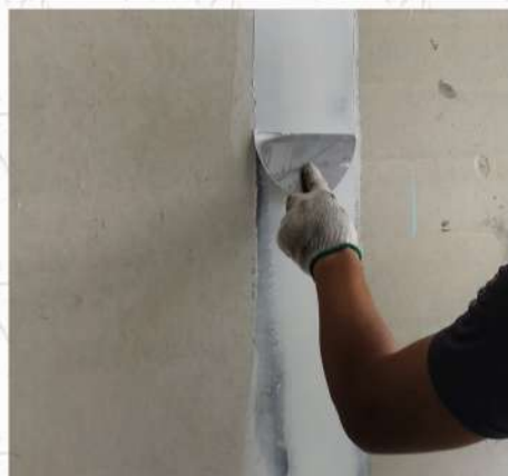
3. Bả dày 1,5 - 2mm lớp bả dẻo D8 Skim kín dọc lớp keo D8 Filler, chờ khô
