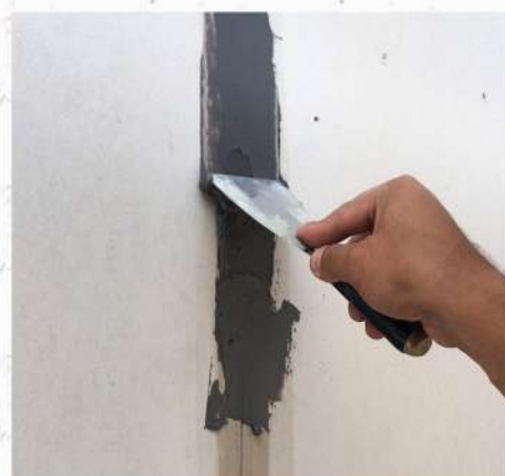
2. Trám phẳng keo D8 Filler dọc khe nối tấm (chờ khô sau 24h)
